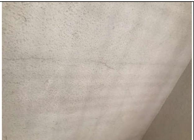
**Foto 24:** Fisuras en revestimiento interior
