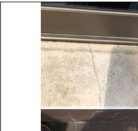
**Foto 46:** Fisura en pieza remate - ventana
