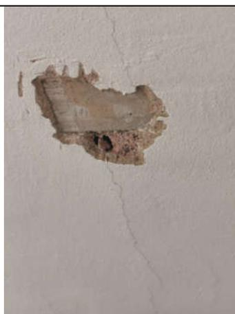
**Foto 36:** Fisura en canto de forjado
