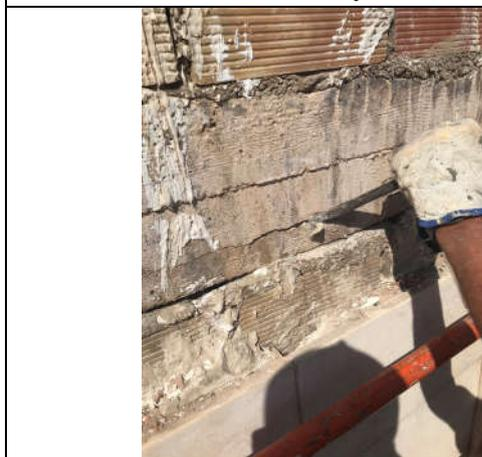
**Foto 31:** Fisura en canto de forjado
