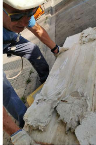
**Foto 38:** Pieza retirada con 2 tramos de canto de forjado de hormigón adherido a la pieza de aplacado.
