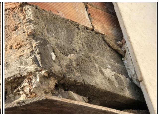
Foto 12: Fisura en canto de forjado
