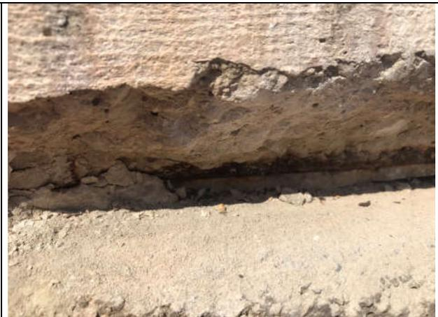
**Foto 44:** Fisura en canto de forjado
