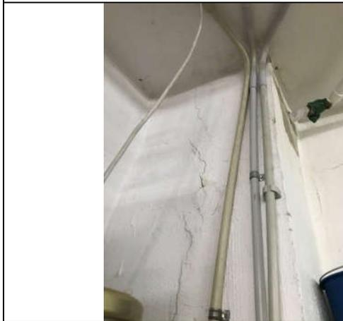
Foto 09: Fisura en pilar
