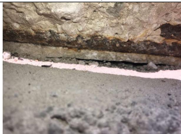
**Foto 32:** Fisura en canto de forjado
