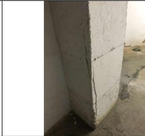
Foto 08: Fisura en pilar
