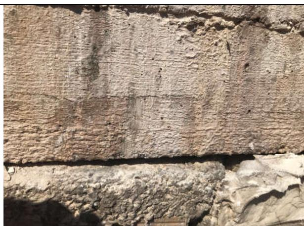
**Foto 30:** Fisura en canto de forjado
