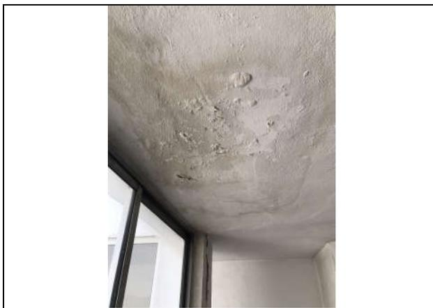
**Foto 28B:** Humedad en trastero de cubierta
