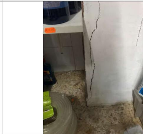
Foto 10: Fisura en pilar
