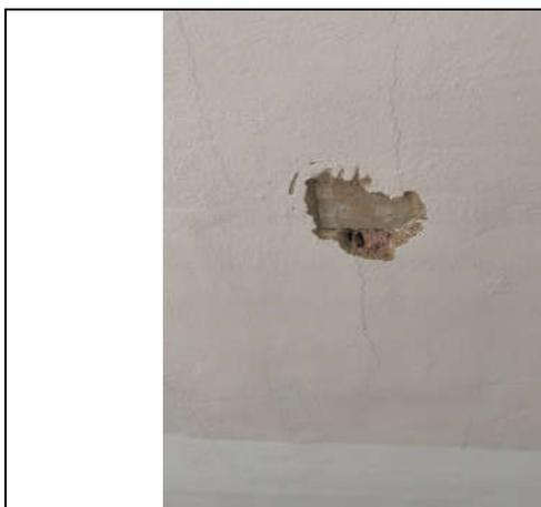
**Foto 35:** Fisura en canto de forjado
